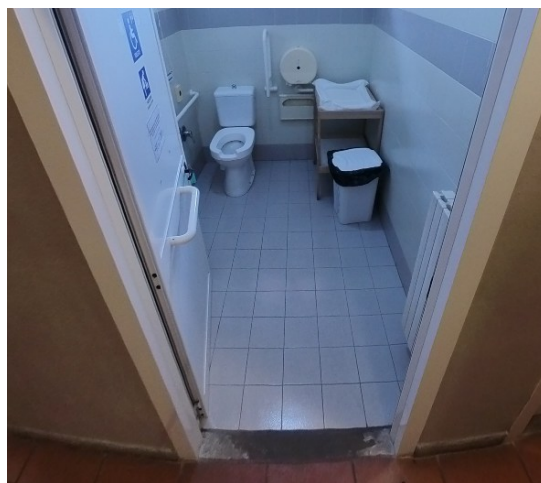
27 interno servizi igienici Palazzina Uzielli
